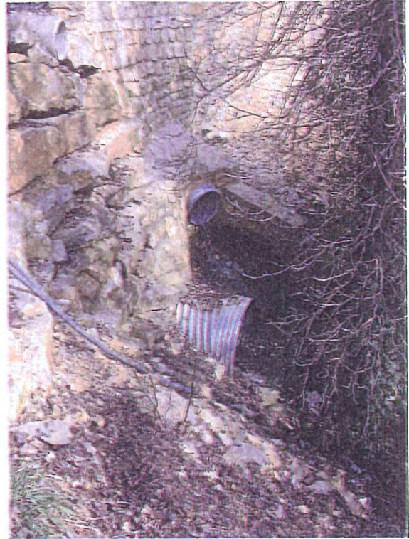
Le passage sous le chemin des Pousets s'effectue par l'intermédiaire d'une buse en tôle de section avoisinant 1 mètre. Le lit à l'aval n'est plus aménagé mais reste encaissé.
