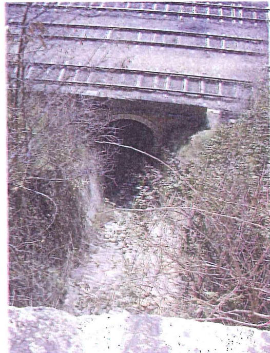
traversée sous SNCF
