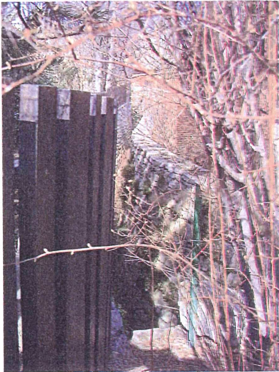
Le Ø 500 débouche dans un chenal en bon état.
