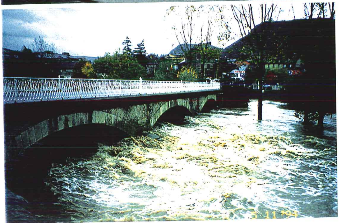
LE PONT ROUPT AVAL
