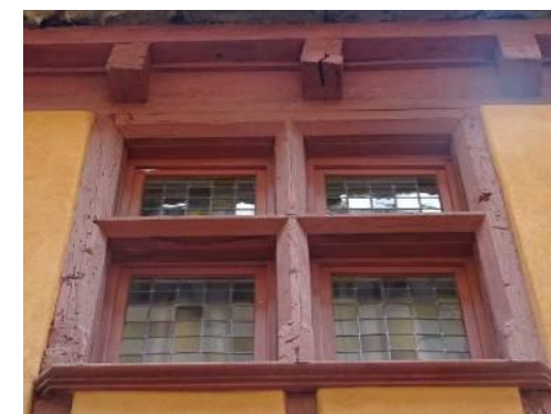
Rue de l'Arjal. Fenêtre à meneau. Seconde moitié du 15e siècle – début 16e siècle.
