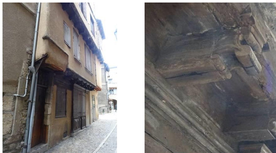
Rue du Fournet. Seconde moitié du 15e siècle – début du 16e siècle. A droite, solives supportant l'encorbellement.
