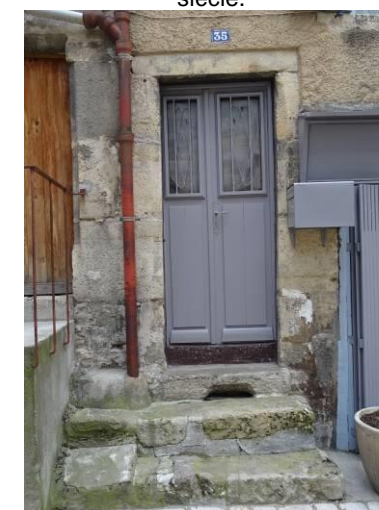
Rue Notre-Dame. Emmarchement extérieur en pierre dans lequel s'ouvre le soupirail de la cave.
