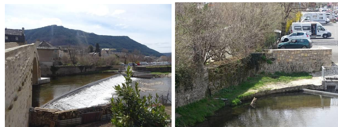
Vue de l'ancien canal de fuite du moulin médiéval du Chastel (détruit).
