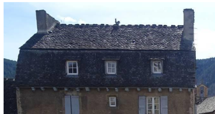
Rue du Pont Notre-Dame. Couverture de lauzes de schiste à brisis et terrasson.
