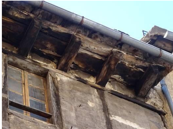
Rue de l'Épine. 15e – 16e siècles. Abouts de solives d'avant-toit moulurés de chanfreins.
