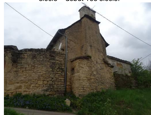
Chanteruéjols, maison des 15e – 16e siècles ? Mur pignon avec cheminée monumentale et son conduit.
