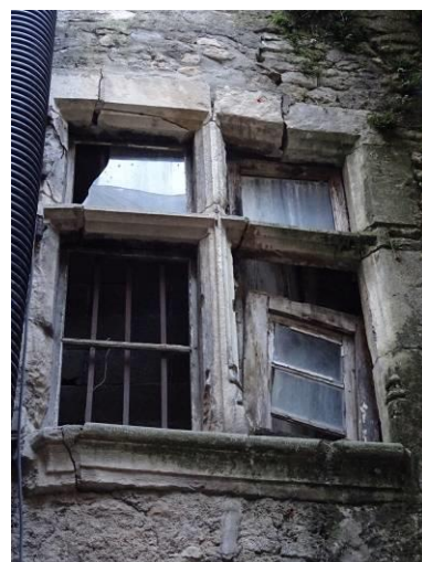
Rue d'Angiran. Fenêtre à meneau. Seconde moitié du 15e siècle – début 16e siècle. Façade sur cour.
