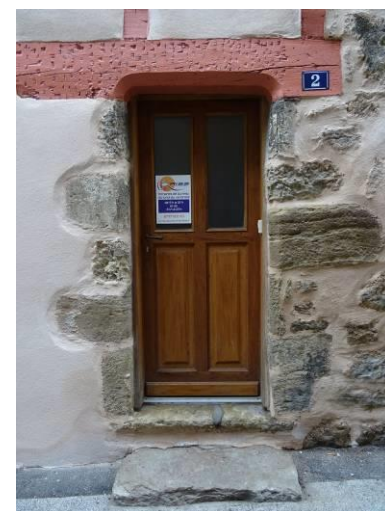
Rue des Finets. Porte de la seconde moitié du 15e siècle – début 16e siècle
