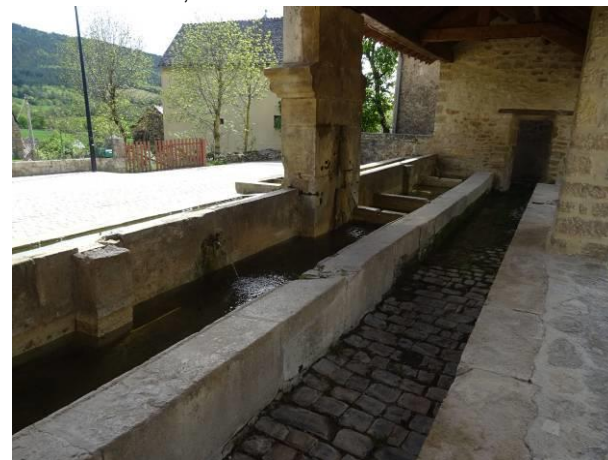
Chabrits, le lavoir de 1879. Vue des bassins
