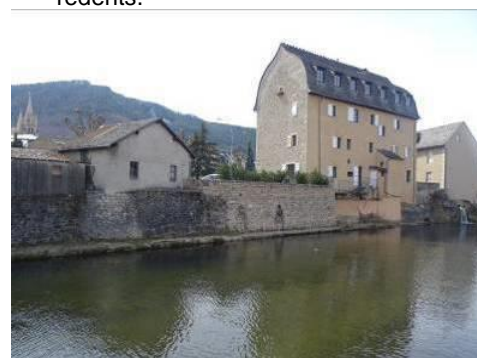
Couverture à la Philibert Delorme (couverture carénée). Rue de l'Épine. Couverture de lauzes.
