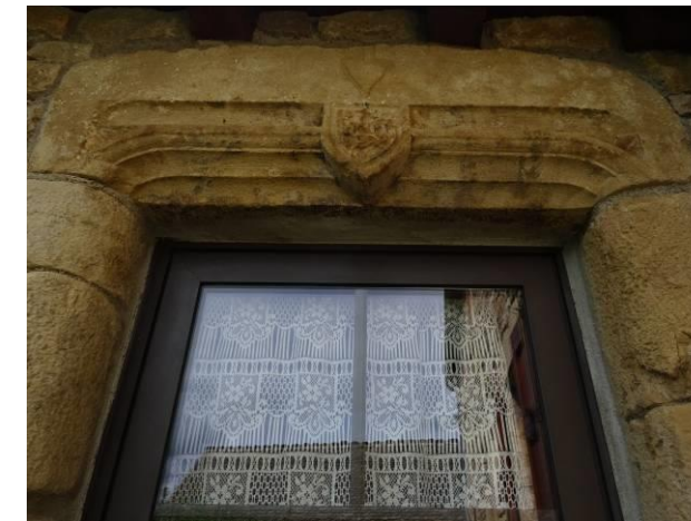
Chabannes, manoir du chapitre. Linteau de porte frappé d'un écu.
