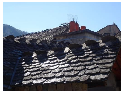
Couverture à la Philibert Delorme (couverture carénée). Rue de l'Épine. Couverture de lauzes.
