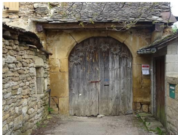
Chabannes. Porche sous couverture de lauzes.
