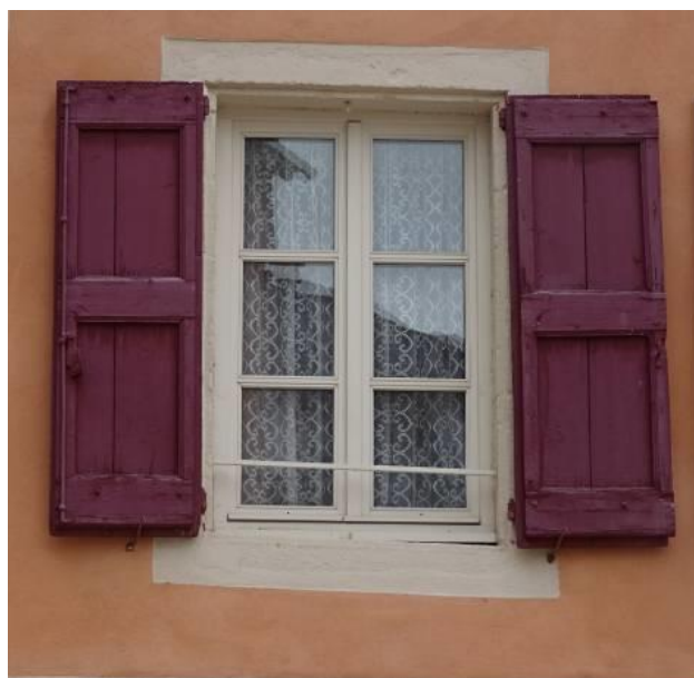
Rue de l'Abbaye. Contrevents en bois à lames larges et intérieur à cadres. 19e siècle.
