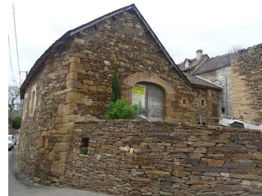
Le Mas. Enclos de ferme en pierre sèche.
