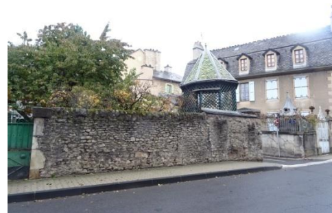
Boulevard Lucien Arnault. Mur de clôture de jardin.
