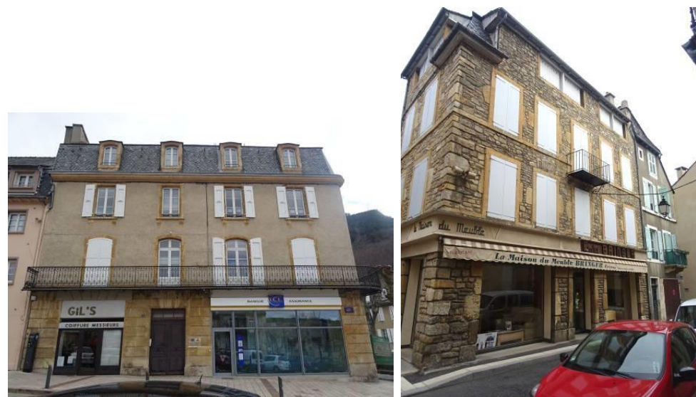
Place Urbain V. Maçonnerie moellonnée enduite. A droite, immeuble, rue Traversière Notre-Dame, en maçonnerie moellonnée jointoyée.
