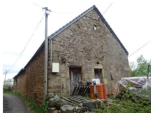
Bahours, logis des 15e – 16e siècles remanié et agrandi au 18e siècle.
