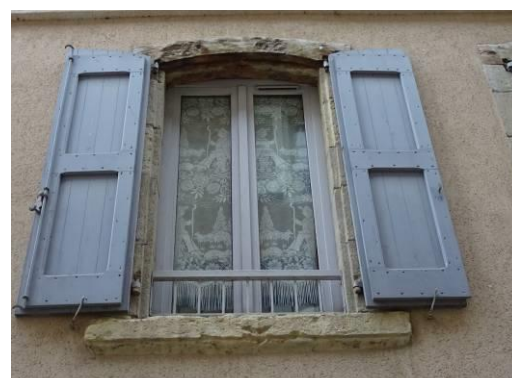
Rue du Chastel. Fenêtre de la seconde moitié du 18e siècle.
