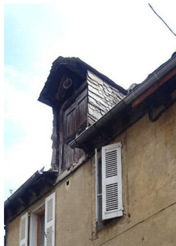
Rue des Bains. Lucarne feunière en bois et sa poulie de levage.
