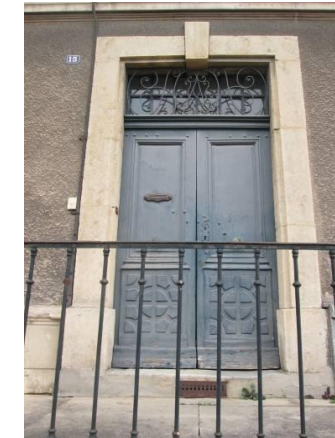
Boulevard du Soubeyran. Ferronnerie d'imposte du 19e siècle.
