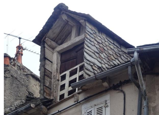
Place du Mazel. Lucarne en bois à joues en ardoises.
