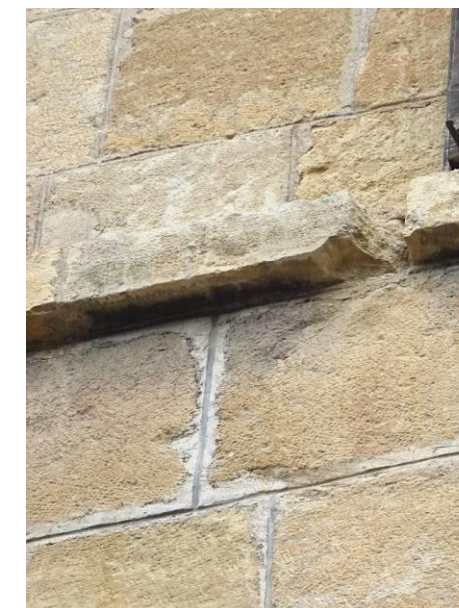
Rue d'Aigues-Passes, 17e siècle. Détail sur le parement du mur et le cordon d'appui.
