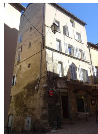
Rue Basse. Immeuble de la seconde moitié du 15e siècle – début 16e siècle.
