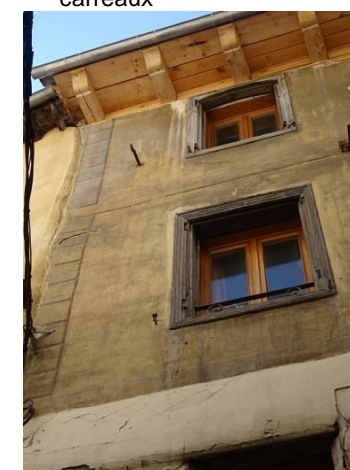
Rue d'Angiran. « Lindages » de fenêtres moulurés. Cadre en bois fixé sur le tableau en bois de l'ouverture contre lequel s'appuie l'enduit de façade
