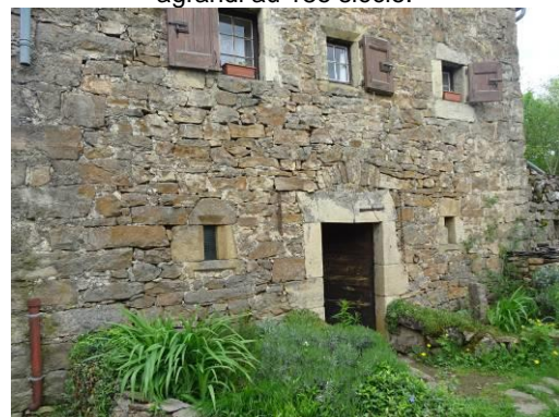
Bahours, logis du 18e siècle, sur base 15e – 16e siècle ? Détail.
