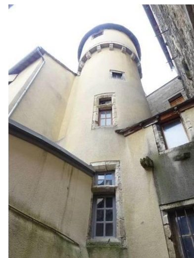
Rue d'Aigues-Passe. Tour d'escalier semi hors-œuvre.
