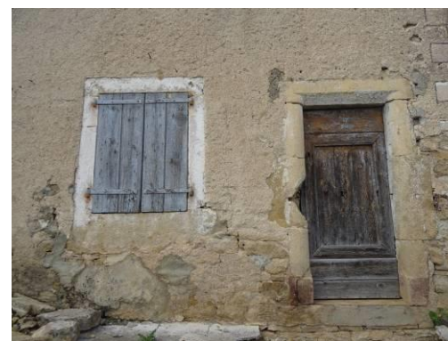
Chabrits, Un enduit de chaux et de sable couvre le parement moellonné.
