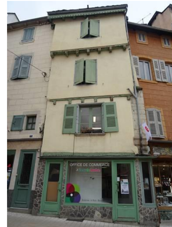
Place de la République. Maison de la seconde moitié 15e siècle – début 16e siècle. Le pan de bois à trois niveaux d'encorbellement est calé à droite sur un mur de refend en saillie appartenant à la maison mitoyenne – la façade de cette dernière ayant été rebâtie en retrait de la rue au 19e siècle.
