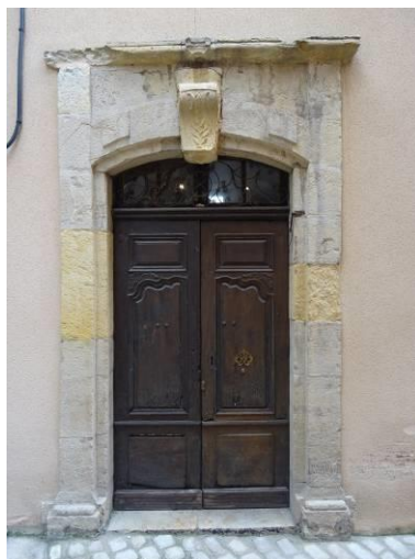
Rue de l'Arjal. Encadrement de porte du 18e siècle.
