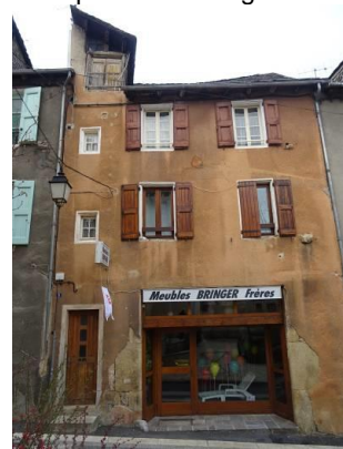
Rue Basse. Lucarne latérale en bois.
