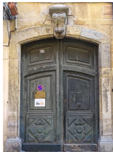
Rue Basse. Portail du 18e siècle.
