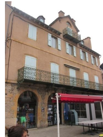
Boulevard du Soubeyran, garde-corps du 19e siècle.
