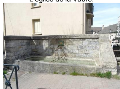
Fontaine du quartier de la Vabre (rue des Ecoles) alimentée par les eaux provenant du mont Mimat. La fontaine fut construite en 1803.
