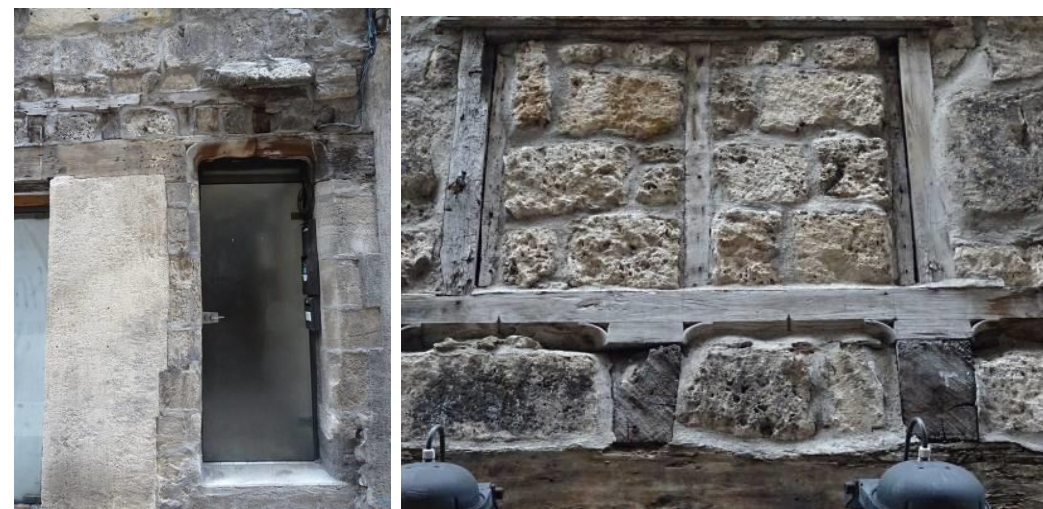
Rue Notre-Dame. La sablière de chambrée et le pan de bois de l'étage de la seconde moitié du 15e siècle – début du 16e siècle, à l'origine en encorbellement sur la rue, ont été déplacés en retrait. Le hourdis se compose de moellons équarris en travertin.
