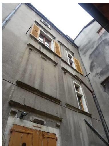
Rue de la Jarrière. 17e siècle.
