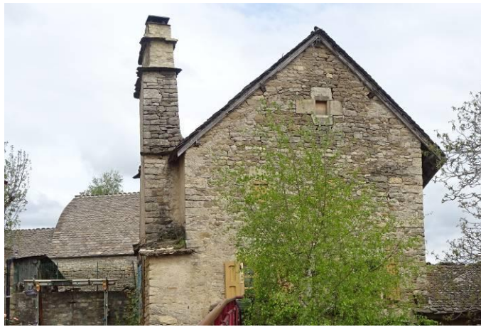
Chabannes, souche de cheminée à redents. 15e – 16e siècles ?
