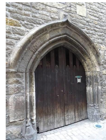
Le portail de la seconde moitié du XVe siècle de la « Synagogue », 17, rue Notre-Dame.
