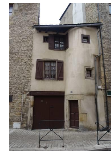
Rue du Collège. 15e – 16e siècles. Tour d'escalier semi-hors-œuvre.
