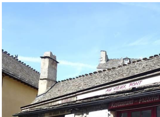
Rue du Pont Notre-Dame. Couvertures de lauzes à deux pans. Souche de cheminée à redents.
