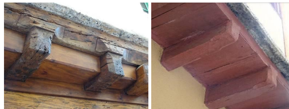
Rue Droite – rue de l'Orange. Sablière de plancher et abouts de solives moulurés de chanfreins et de congés en cuiller. Seconde moitié du 15e siècle – début du 16e siècle. A droite, maison, rue de l'Arjal. Solives supportant l'encorbellement de l'étage. Les abouts sont moulurés de chanfreins et de congés en cuiller.
