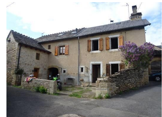
Chabrits, cour fermée d'un mur bas en pierre.
