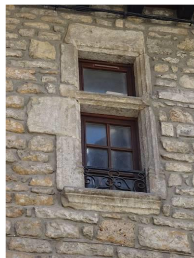
Rue d'Angiran. Fenêtre à traverse. Seconde moitié du 15e siècle – début 16e siècle.
