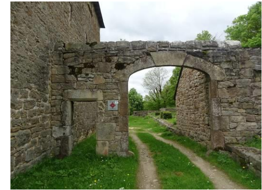
Bahours, maison forte. Portail charretier.
