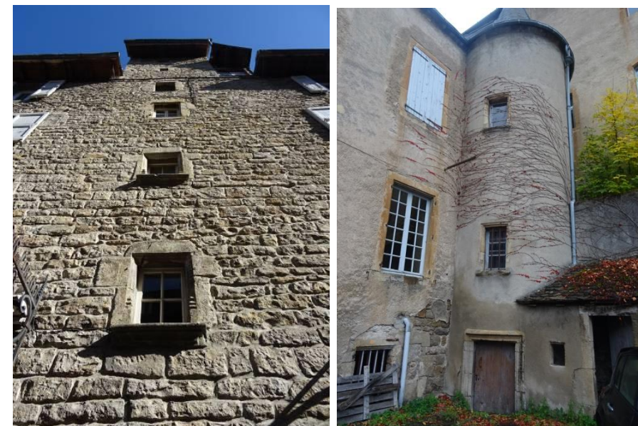
Rue d'Angiran. Seconde moitié du 15e siècle – début du 16e siècle. Tour d'escalier dans l'œuvre. A droite, tour d'escalier semi hors-œuvre du 16e siècle, rue des Ecoles (Faubourg de la Vabre).
