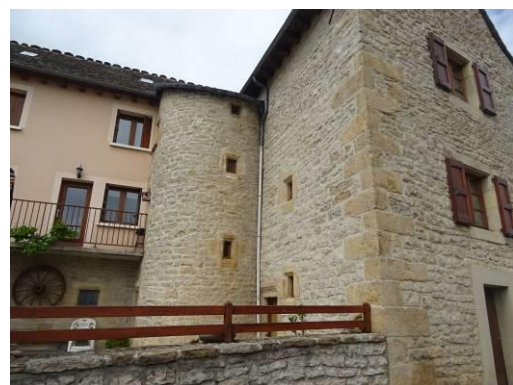
Chabannes, repaire de la seconde moitié du 15e siècle – début 16e siècle. La tour d'escalier en vis est placée hors œuvre.
