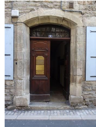
Rue Basse, ferronnerie d'imposte de porte du 18e siècle.
