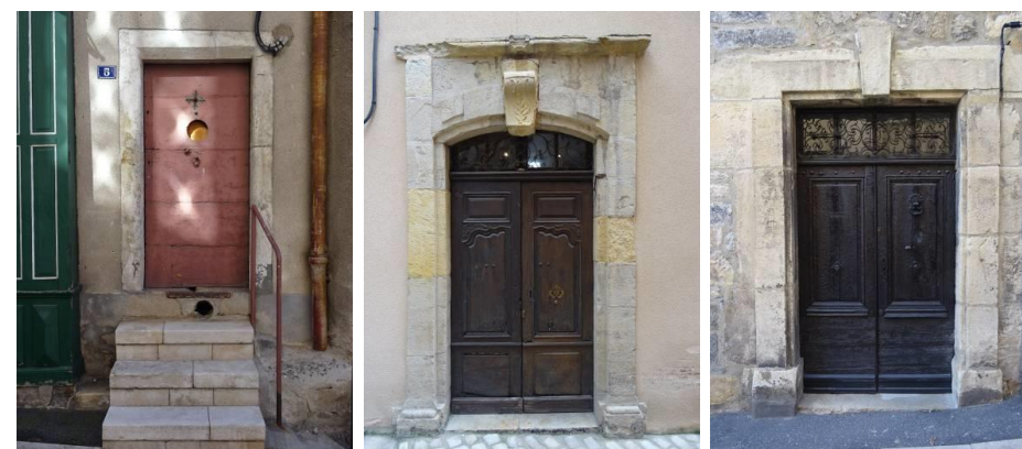
Rue de l'Arjal. Double vantail de style Louis XV. 18e siècle. Au centre, Place du Mazel. Vantail à larges lames horizontales. A droite, place du Mazel. Vantaux et imposte en ferronnerie fin 18e – début 19e siècle.
