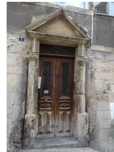
Rue de l'Arjal. Porte du 17e siècle sous fronton triangulaire en encadrée par deux colonnes à chapiteaux toscans.
