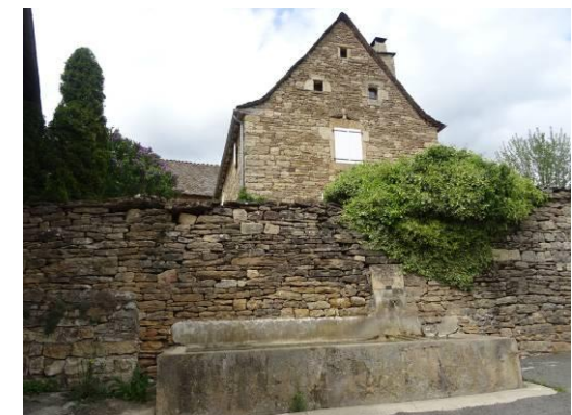
Chabannes. Murs d'enclos en pierre.
