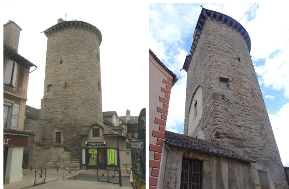
Vue du flanc droit de la tour d'Auriac (tour des Pénitents). La tour d'Auriac vue de la place au Blé.
