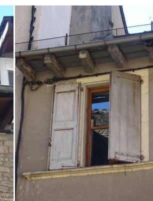
Rue d'Angiran. 15e – 16e siècles. Abouts de solives d'avant-toit profilés de chanfreins et de congés en cuiller.
