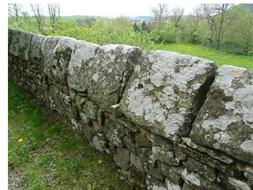
Bahours, maison forte. Mur d'enclos à couronnement de pierres triangulaires.
