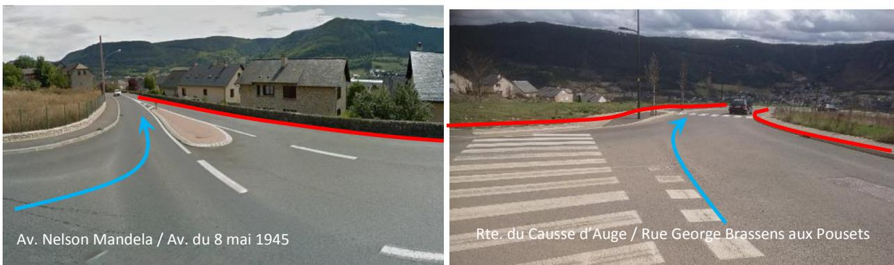
*Illustration 3 : Eléments structurants des voiries canalisant les écoulements*
